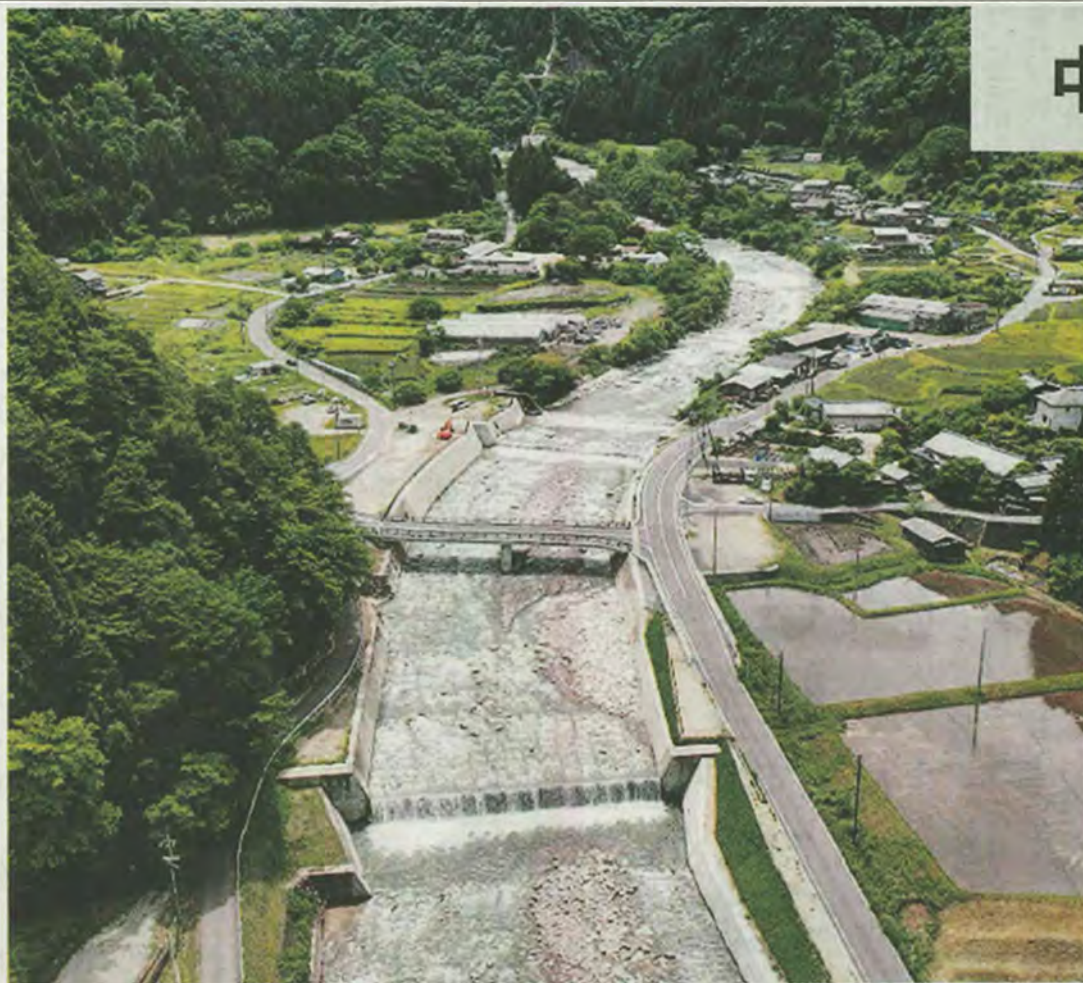
大規模な改築を終えた川上流路工。手前の段差が砂防堰堤、中央の宮前橋の奥にいくつか見える段差が床固工＝中津川市で(多治見砂防国道事務所提供)
